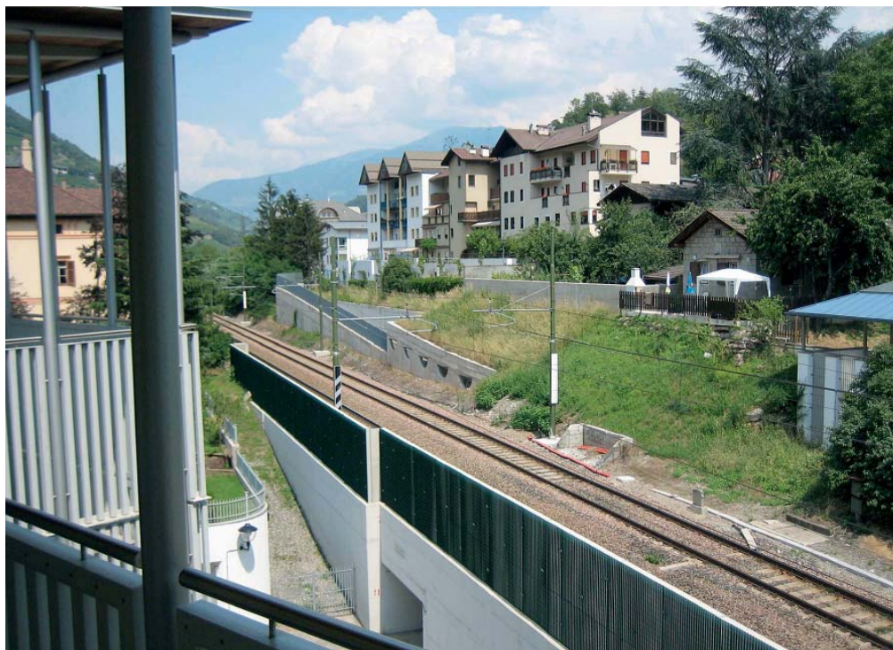
I binari visti dal „Krautgartner“: Qui le barriere antirumore servono a ben poco.
