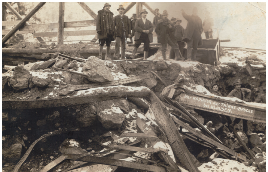
Der „Kadaver“ der Tinnebrücke an der Mündung, 1922/23
