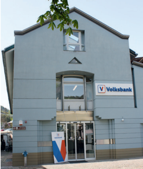
Die Volksbank-Filiale in Klausen am Tinneplatz wurde einer vollständigen Renovierung unterzogen
